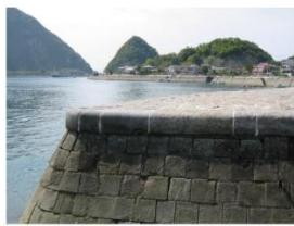
8 三角旧港(三角西港)の施設関連遺産
